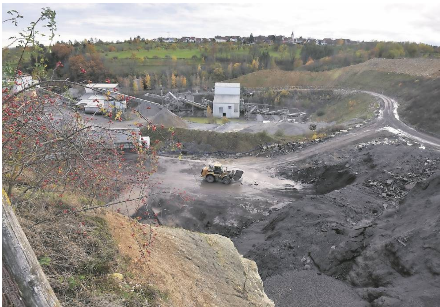
Verarbeitungsanlage und Technik im Haslacher Steinbruch beschäftigten das Verwaltungsgericht
